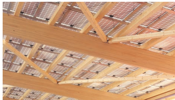
Industriegebäude mit Hauptbinder aus Buche-Brettschichtholz; Skyaccess AG, Oensingen
